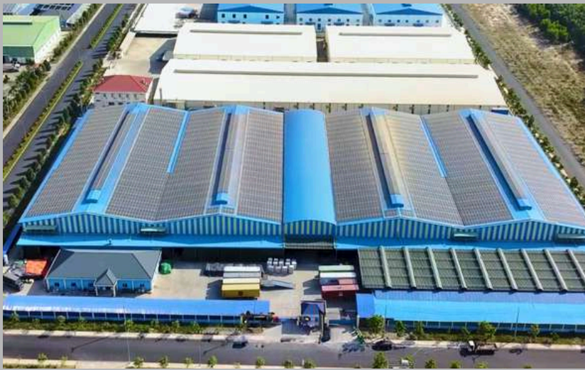
Hình ảnh 2: Nhà máy Sanyang 2
